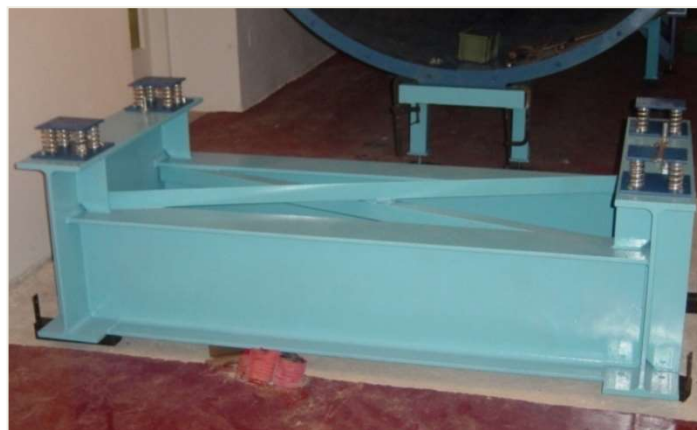
Figura 7 Vista del basamento su fondazione rigida
